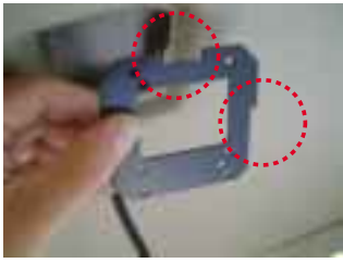
TV基台Bを天井内に入れます。 ※形状の方向に注意。
