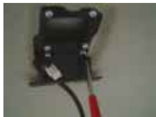
センターをあわせ、付属のねじ でTV基台A・Bを固定します。 (6ヶ所) ⑥なべ小ねじM5X10 ⑧スプリングワッシャーM5 ⑨ワッシャーM5
